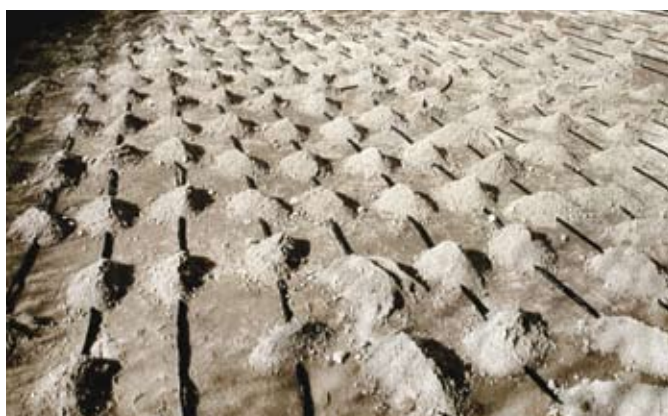
Fig. 48: Umplerea și acoperirea sistemului de tuburi
