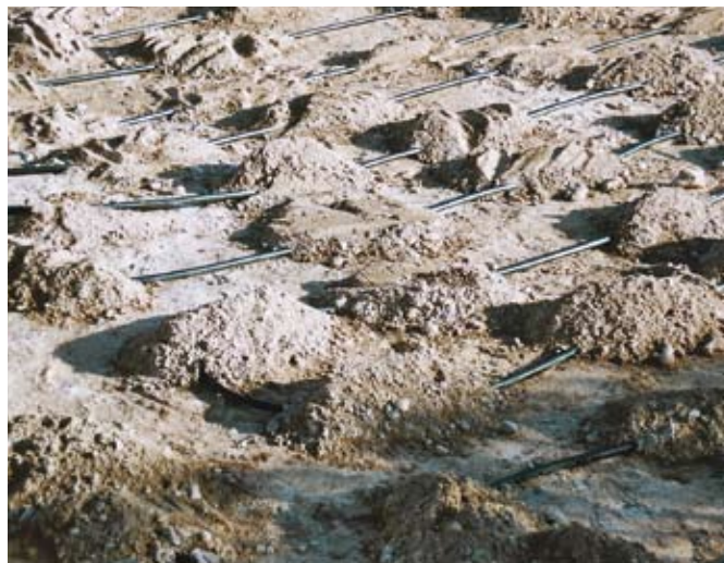
Fig. 12: Pozare tub colector RAUGEO PE 100
