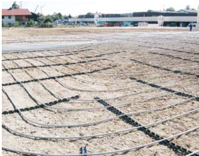
Fig. 10: Pozarea tubului colector RAUGEO PE-Xa
