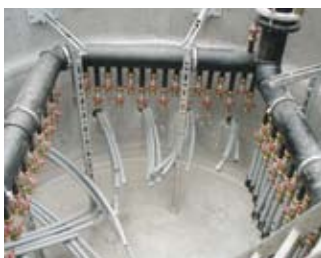
Fig. 25: Distributor de apă sărată
