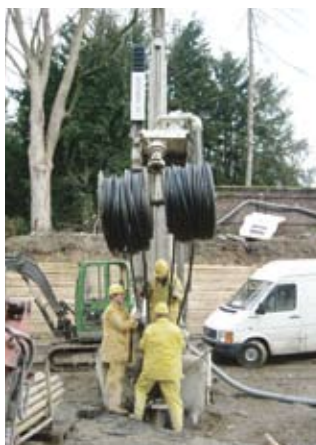
Fig. 7: Introducerea unei sonde RAUGEO PE 100
