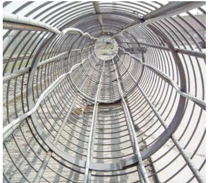
Fig. 15: Tuburi RAUGEO collect PE-Xa montate în colivia de armătură
