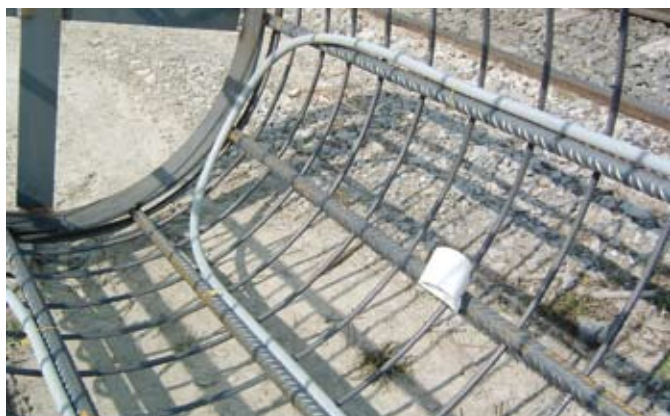
Fig. 58: Montajul conductelor la carcasa de armătură
