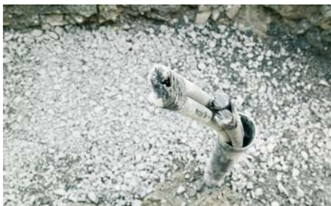
Fig. 53: Presarea găurii forate
