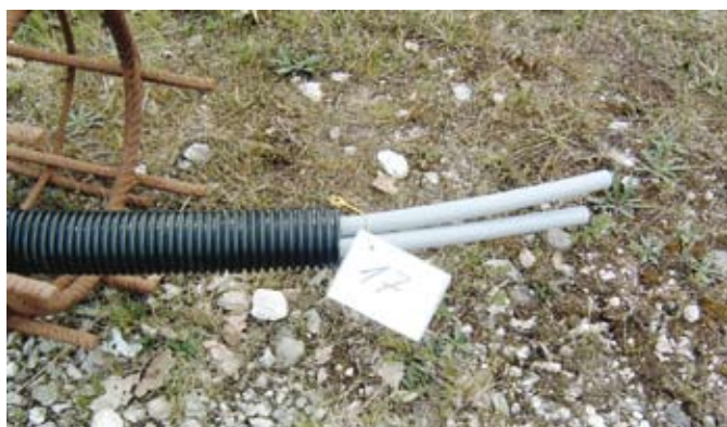
Fig. 59: Combinarea turului și returului în tubul protector
