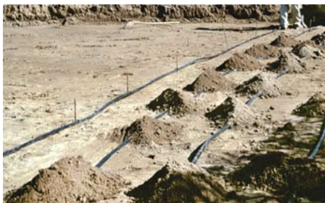
Fig. 47: Acoperirea tuburilor cu pământ sau nisip
